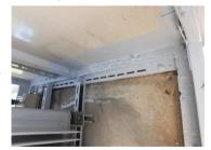
サビ落とし→サビ転換剤塗装→サビ止め塗装で腐食の進行を抑えます。
